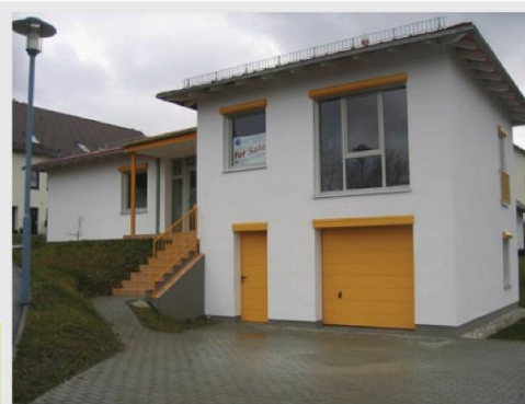
Einfamilienhaus Plauen (Baujahr 2006)
